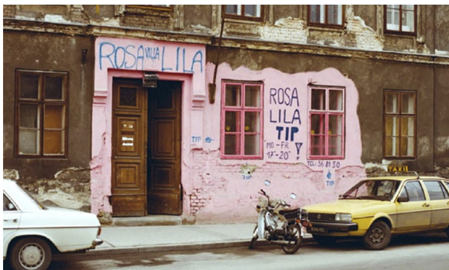
Abb. 2: Die Fassade der Rosa Lila Villa vor der Sanierung in den Jahren 1987/88.
