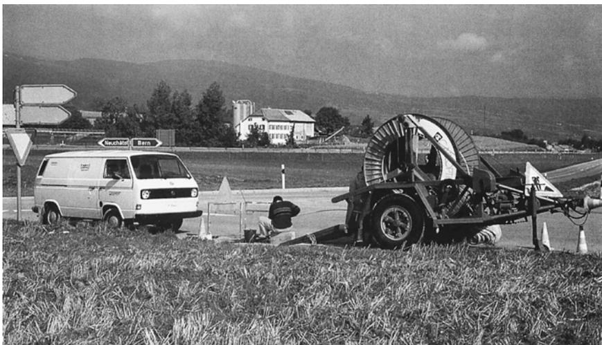
Abb. 5: Einziehen von Glasfasern, irgendwo zwischen Bern und Neuchâtel.
