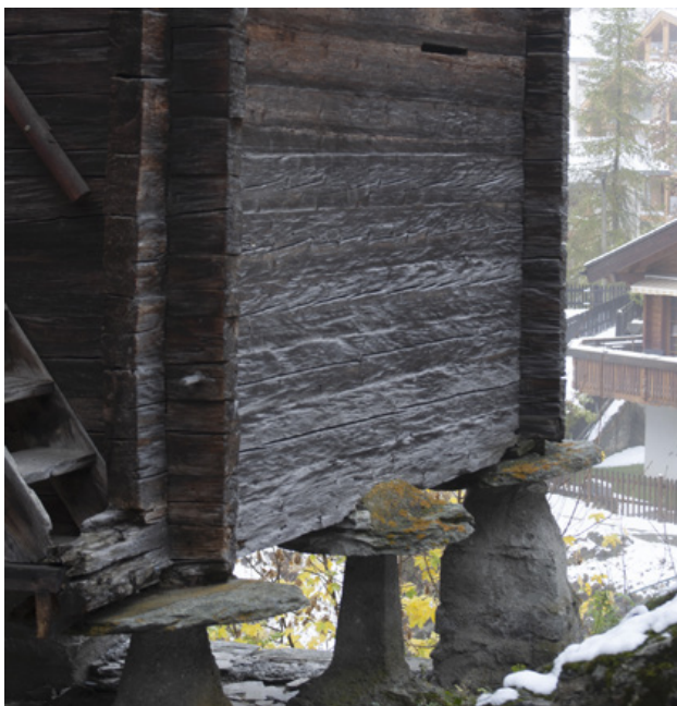
Abb. 5: Speicher im Miteigentum der Familie Eyer in Blatten, auf Stelzen mit Mäusetellern und Luftschlitz, 2018.
