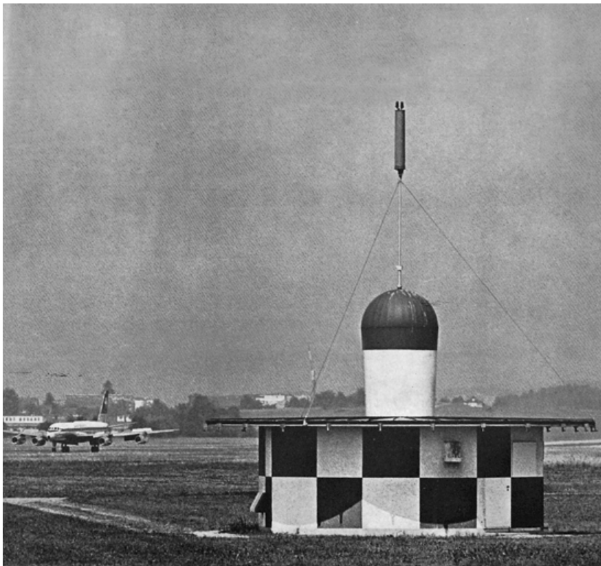
Abb. 3: Drehfunkfeuer am Flughafen Zürich-Kloten, 1970.
