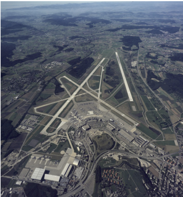
Abb. 6: Blick aus dem Süden auf den Flughafen im Ausbauzustand von 1977. Links im Bild ist die begradigte Glatt erkennbar, daneben die Waldstücke, die nach dem Bau des Flughafens übrig blieben.
