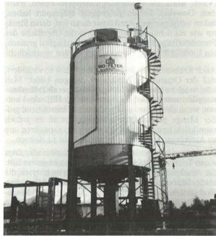
Biofilter zum Abscheiden gasförmiger organischer Verunreinigungen aus Abgasen. (Foto: Gebr. Weiss, Dillenburg)
