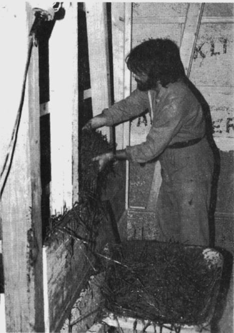
Vor den Holzriegel dieser Aussenwand wird eine Schalttafel genagelt und mit Strohlehm hinterfüllt.
