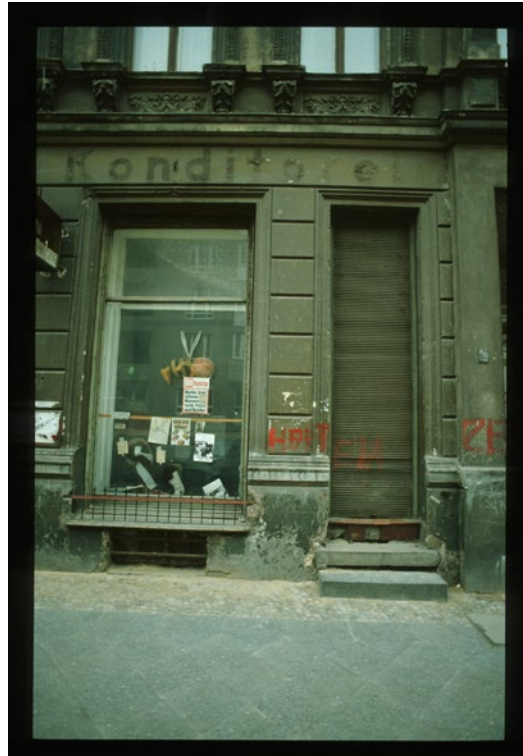
Ladenfassade, Naunynstraße, S.T.E.R.N.-Fotobestand, 0216/K/07-0216/K/08, FHXB.
